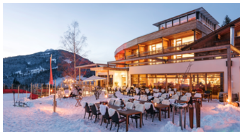
Figure 9: Holzhotel Forsthofalm, Austria
